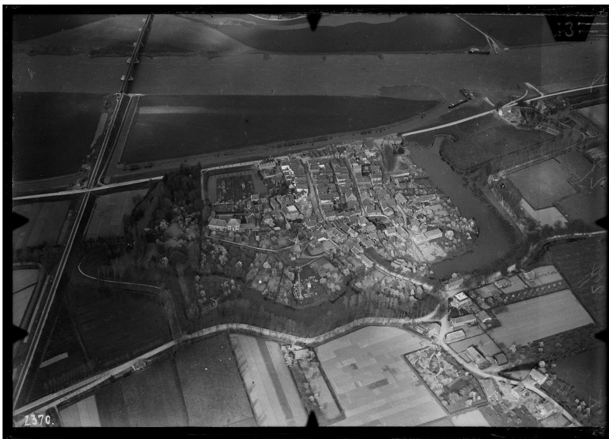
Figuur 62. De geconserveerde vesting Ravenstein in de jaren twintig of dertig (bron: NIMH).
