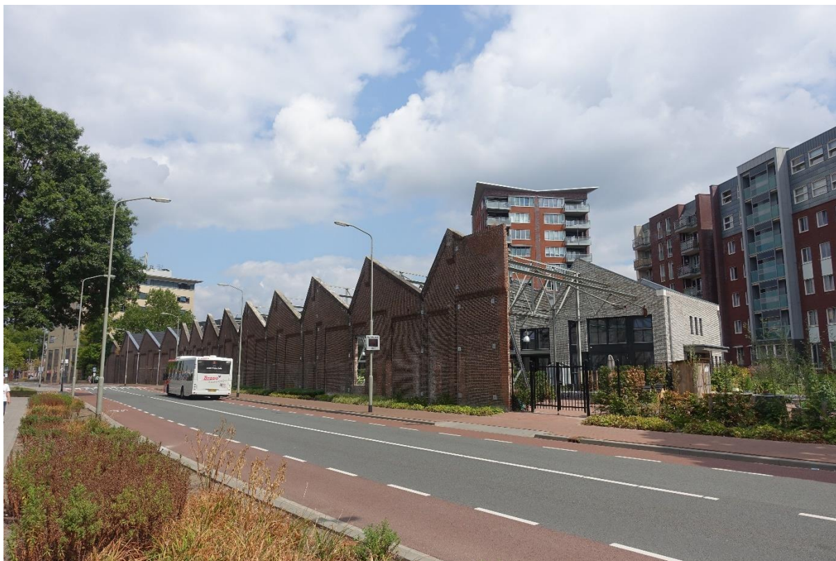
Figuur 77. Relicten van historische bedrijvigheid in het centrum van Oss, ingepast in herontwikkelingsproject (foto MAB, 2022).
